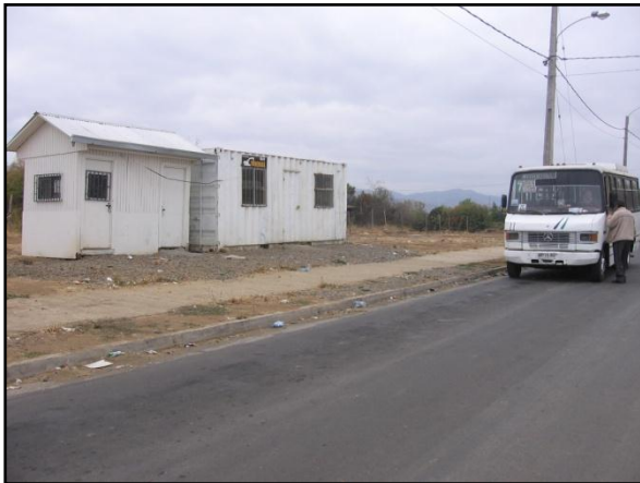
Figura 25. Punto Retorno línea 7. Emplazado en 23 oriente con 22 Norte
