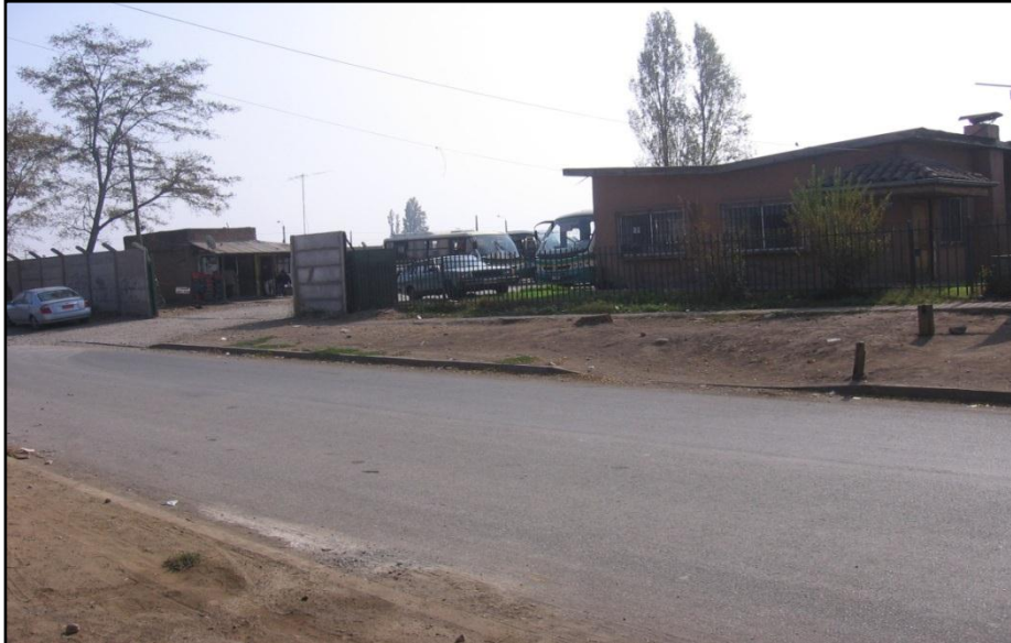
Figura 39. Terminal líneas Santa Fe y Boldo. Emplazado en 21 de mayo N° 1159
