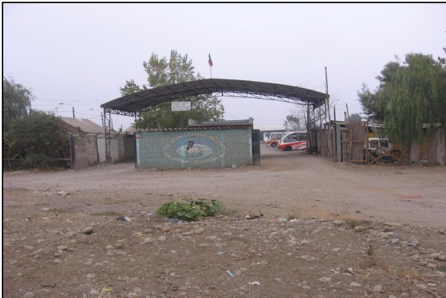
Figura 40. Terminal líneas 1, 2, 3, 5 y 8. Emplazado en Trapiche N° 533
